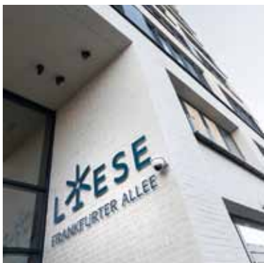
Howoge-Projekt Liese in der Frankfurter Allee: Tiefgarage für Fahrräder statt Autos, Zugang zu U- und S-Bahn nahe am Haus
